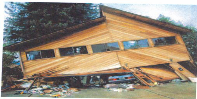
这所房子位于圣塔克鲁斯山区，在 1989 年 6.9 级的 Loma Prieta 地震中倒塌 (USGS photo)。
